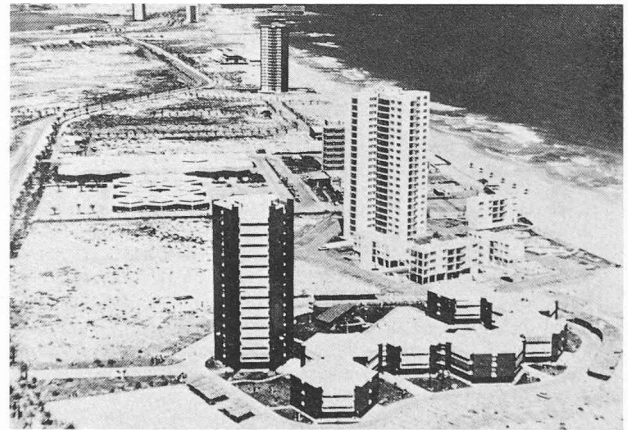
... entre d'autres façades de béton
