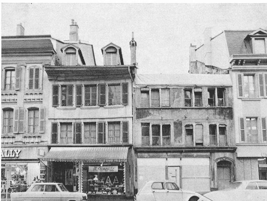
Fig. 3. — Grand-Rue 73 et 75 : immeubles mitoyens après l'incendie du 12 novembre 1970.
