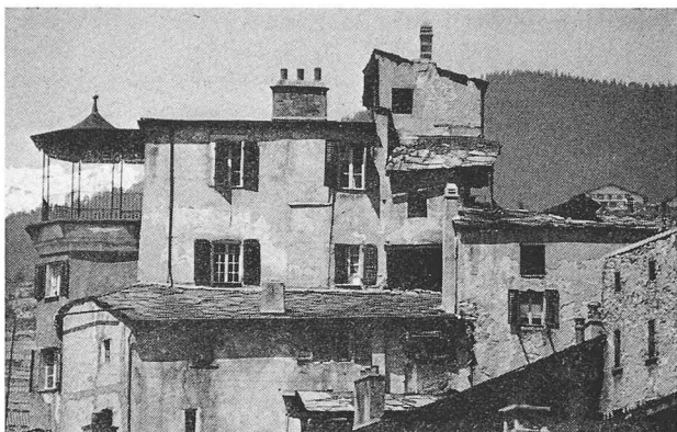
Fig. 3. — Maison de Platea : façade sud avant la restauration.
