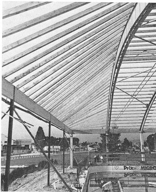
Fig. 6. — Poutre de pignon et charpente d'extrémité.
