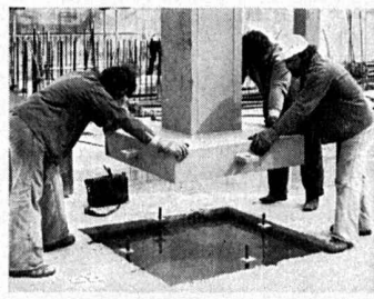
Montage de colonnes du centre interurbain des PTT à Zurich-Herdern: De lourdes colonnes doivent supporter les bâtiments élevés à grandes charges utiles de plancher.
