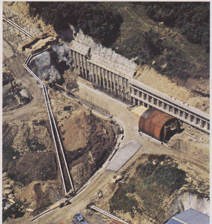
Fig. 10. — Vue aérienne de la zone du portail nord. De droite à gauche : tranchée précédant le tunnel ; coffrage métallique préparé pour le bétonnage de la voûte ; zone de congélation du terrain ; conduites de congélation.
