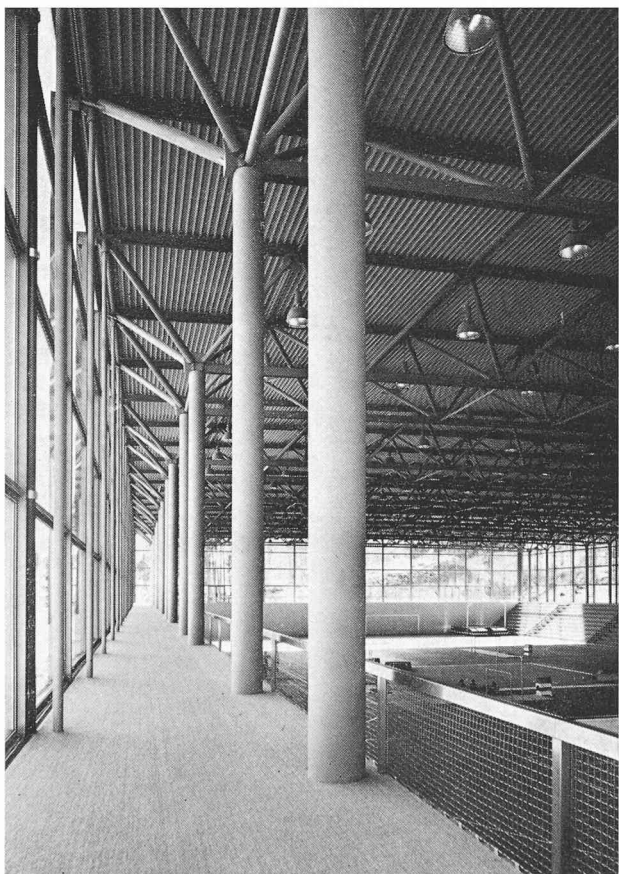
Fig. 1. — Intérieur de la halle omnisports. On remarquera la structure en treillis du plafond.
