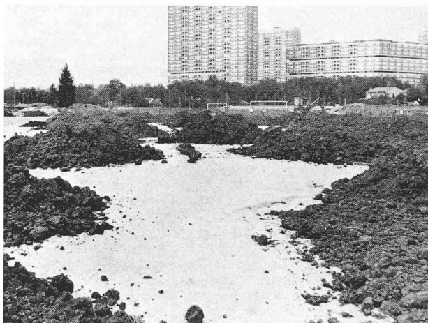
Mise en place de la terre végétale sur les nappes de Bidim, le sol étant préalablement nivelé et recouvert de grave.
