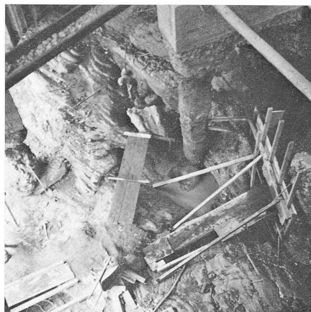
Fig. 5. — Dégagement d'un pieu coulé dans le sol.
