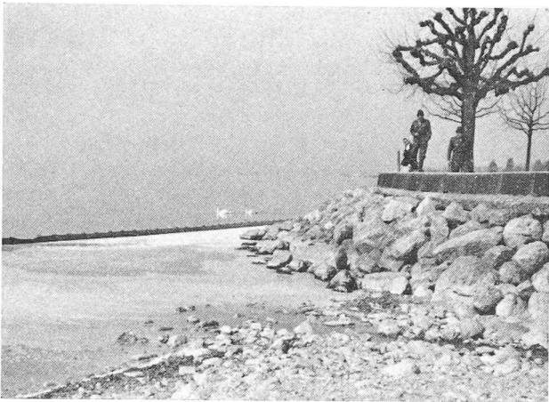
Barrage du type écran, à l'embouchure d'un ruisseau pollué par des hydrocarbures, au droit de la Tour Haldimand, à Lausanne. « Les produits absorbants, gorgés d'hydrocarbures, sont ensuite récupérés à l'intérieur du barrage. »
