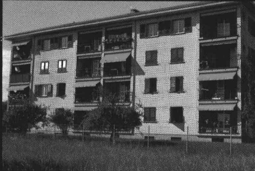
Volets d'immeubles locatifs à Bussigny
