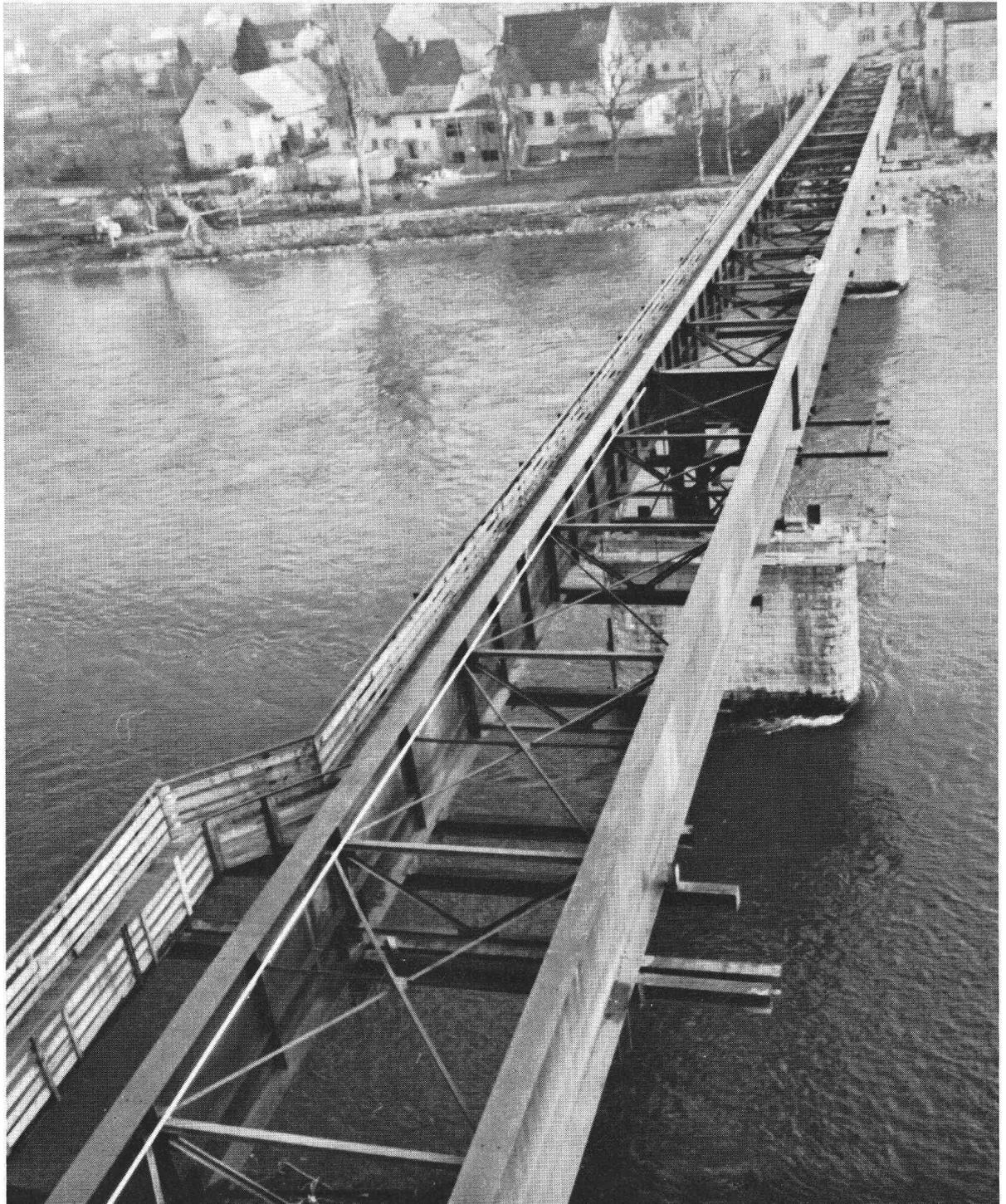
Phase de construction du pont mixte sur le Rhin entre Rheinheim (RFA) et Zurzach (CH)
