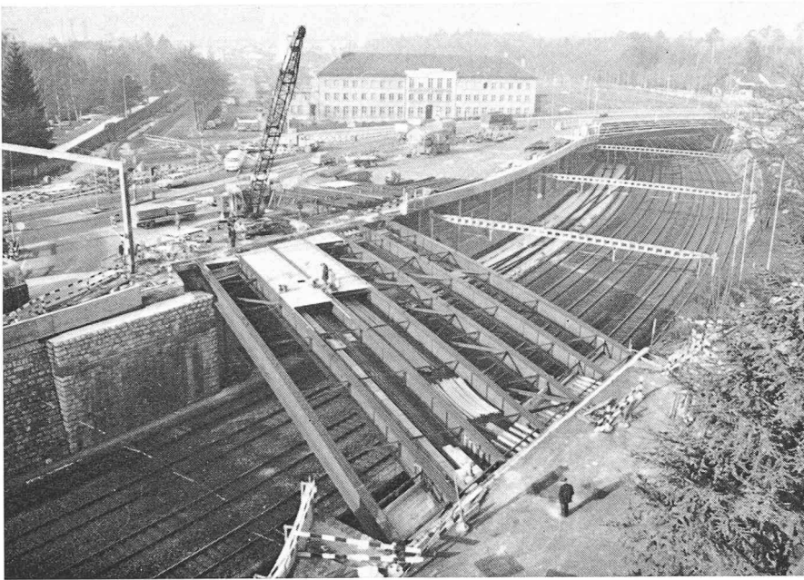
Fig. 3. — Vue du pont A2 pendant la construction.
