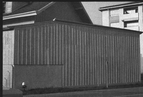
Réfection d'un hangar en bois à Bussigny
