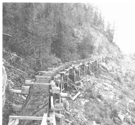
Irrigation hier : l'ancien bisse de Saxon traversant des terrains mouvants.
