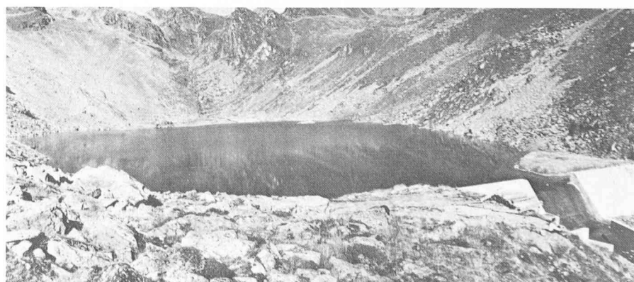
Irrigation aujourd'hui : le bassin de Louvie (val de Bagnes). Altitude : 2210 m ; capacité : 150 000 m 3 . Louvie-La Chaux : galerie de 3700 m ; La Chaux - Pierre-Avoi : acueduc de 11 km ; galerie de la Pierre-Avoi : 700 m ; Pierre-Avoi - Pas-du-Lin : conduite de 3300 m.
