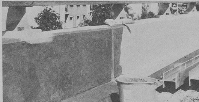
A gauche, parapet en béton revêtu; à droite, parapet préalablement enduit de Rivalfix 7. (Photo Meynadier.)
