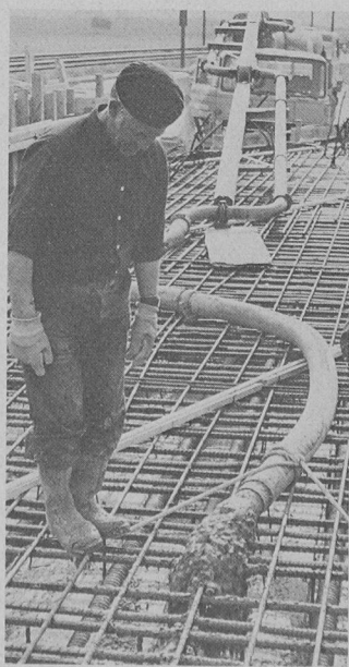
Vue prise au cours du bétonnage. (Photo Zschokke.)
