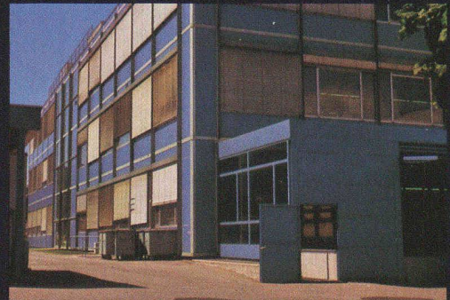
Immeuble Kodak à Renens
