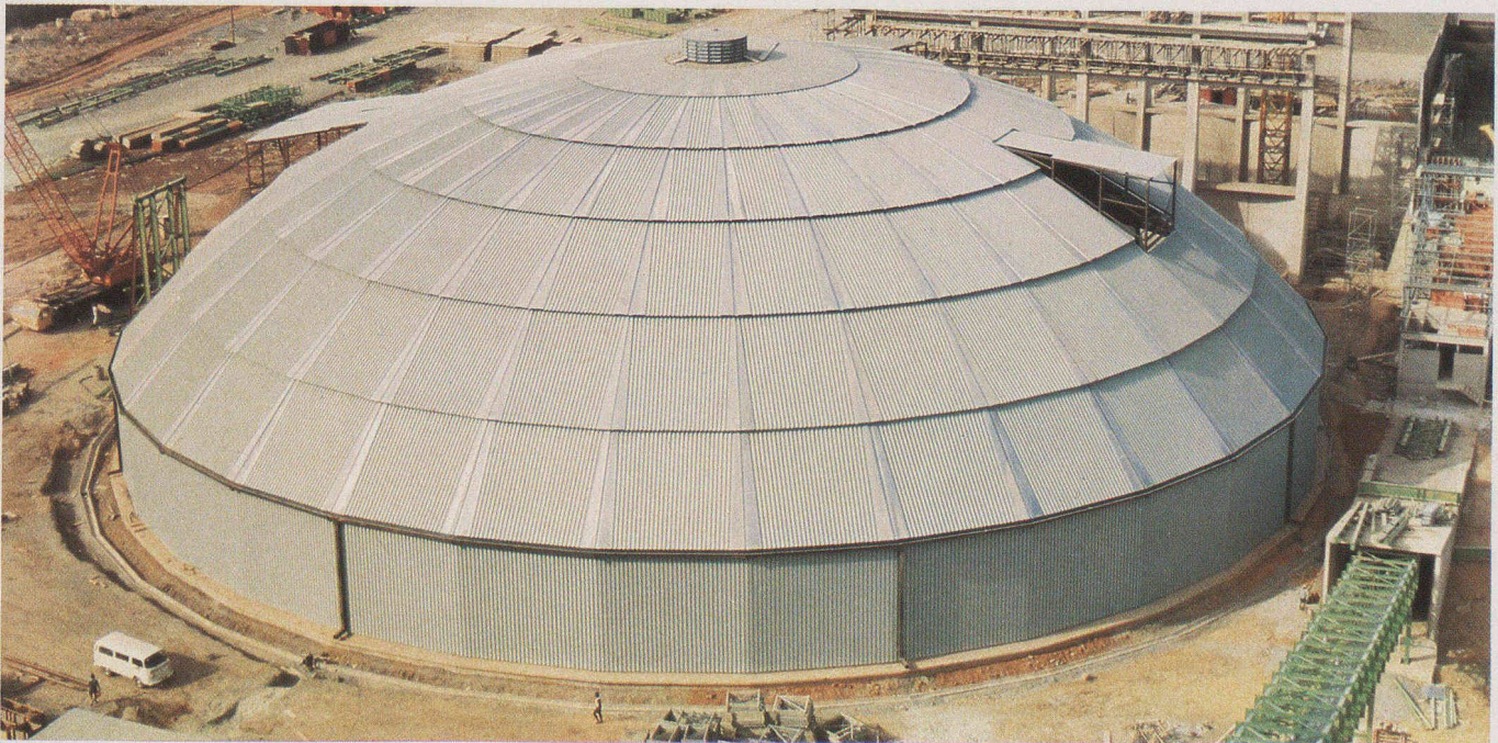
Fig. 9. — La coupole terminée.
