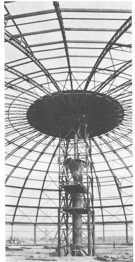
Fig. 7. — Montage à l'aide d'une tour.
