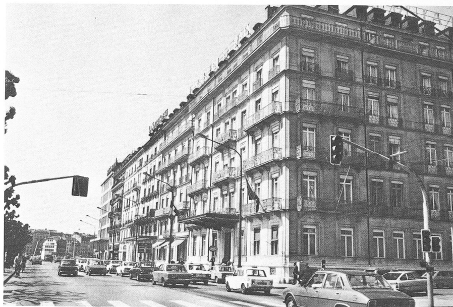
Ordonnance de façades du XIX e siècle : le square du quai du Mont-Blanc.
