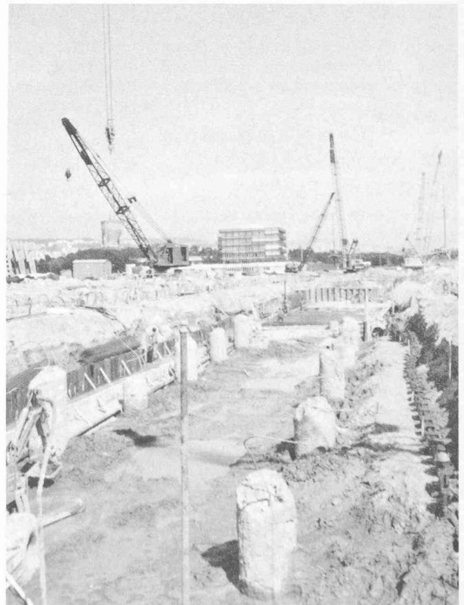
Fig. 10. — Pieux de fondation d'une galerie technique.
