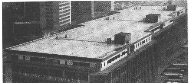
B488 Port-franc, Genève – Architecte: Koehlin René et Mozer Marc, Genève 7'000 m 2 fixés mécaniquement
