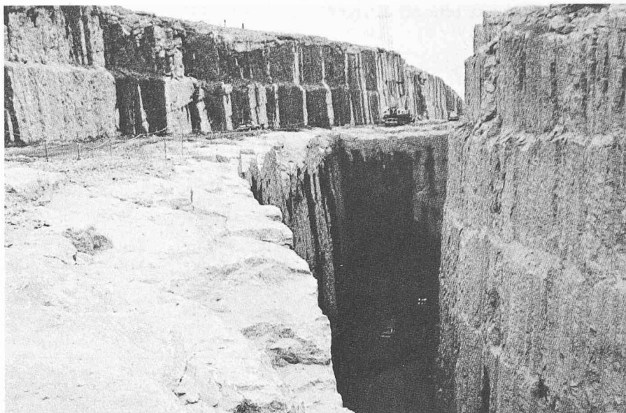
Fig. 23. — Photo des galeries superposées, dessus l'évacuateur des crues, dessous la galerie de dérivation.
