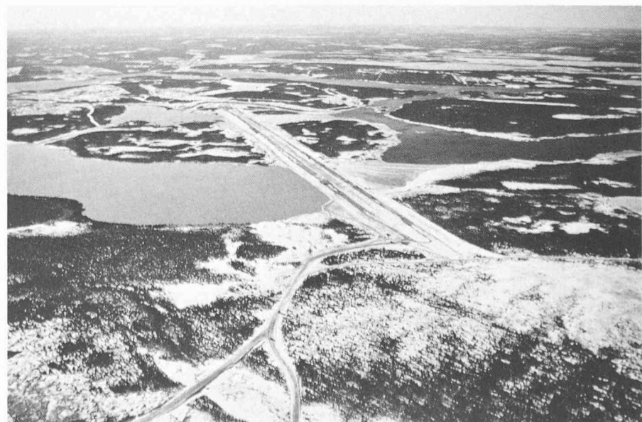
Fig. 22. — Photo du barrage en voie d'achèvement.
