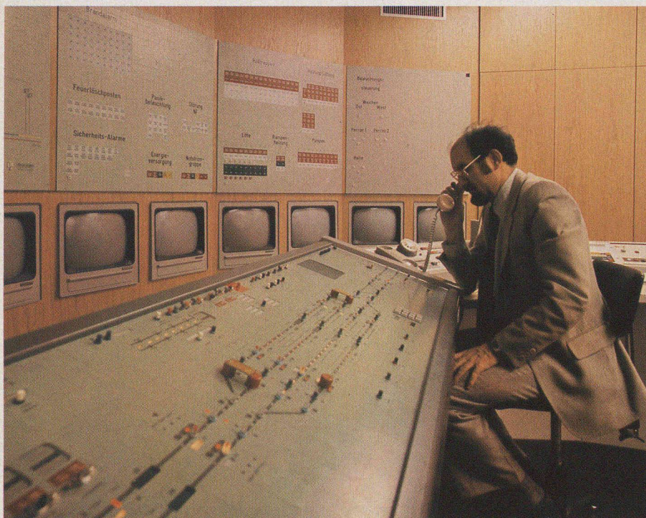
Fig. 8. — Station de commande.
