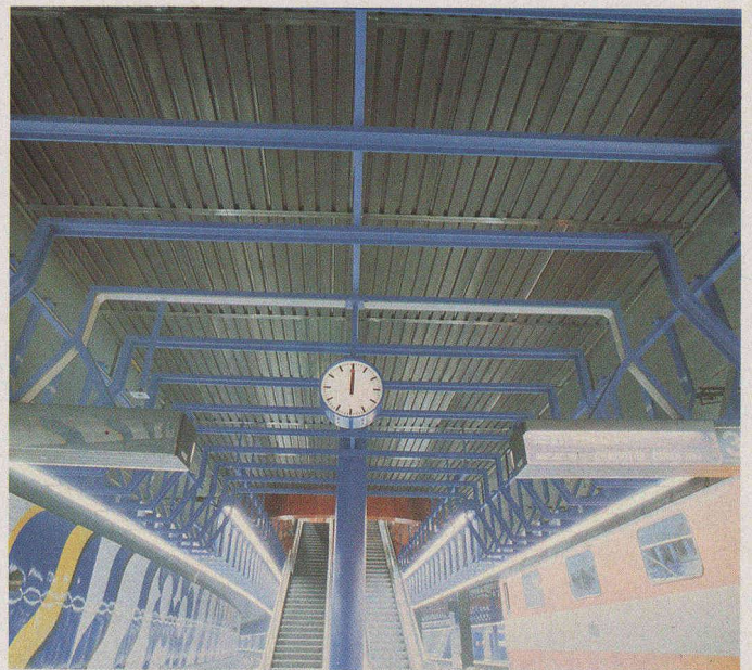
Fig. 4. — Construction nervures au-dessus de l'étage des quais.
