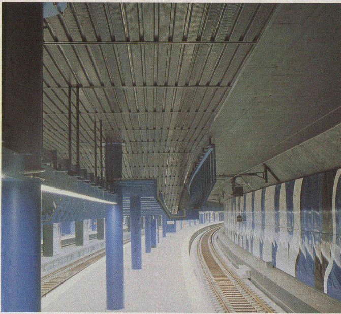
Fig. 3. — L'étage des quais avec piliers en acier.
