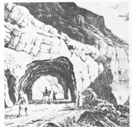
Le trou d'Uri, le plus vieux tunnel routier alpin du monde, fut percé en 1707 par le tessinois Pietro Moretini. Il fut dès lors possible d'éliminer un des passages les plus critiques de la route du Gothard, le « Twärrenbrücke », passerelle de bois suspendue contre la roche du Kirchbergfels dans les Schöllenen.
