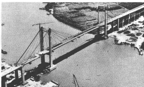
Câbles de haubans BBRV-HiAm pour le pont sur le Rio Paraná, Argentine.
