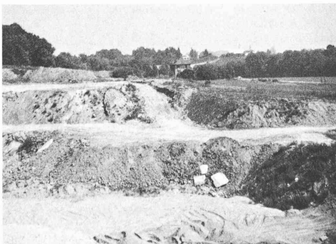
Fig. 5. — La décharge pour matériaux terreux et pierreux sains au nord de la route cantonale Buchillon-Allaman.
