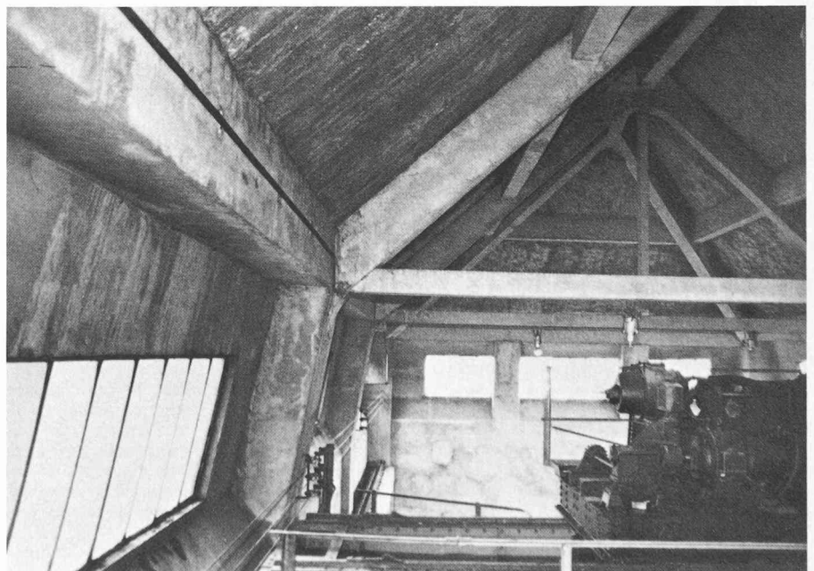
Ancienne usine hydro-électrique de Chèvres (Vernier/GE). Intéressante structure de la toiture, en béton ; à droite treuil sur pont roulant (capacité de levage : 40 t) construit par les Ateliers Jonneret. Ce bâtiment, édifié dans les années 1916-1920, sera démolí sous peu. L'API envisage la possibilité de sauvegarder tout ou partie du treuil. De plus, aucun dossier de construction n'étant conservé, l'API s'efforcera de combler cette lacune avant et pendant la démolition (photos, croquis, enregistrement vidéo) afin que ne disparaisse pas totalement un témoignage de l'architecture industrielle de ce siècle. Document API/Photo Atelier Pattusch.
