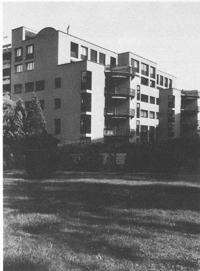
Fig. 12. — Immeuble Gartenstrasse, vu de l'ouest (ci-dessus).
