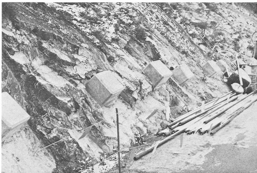
Fig. 14. — Ancrages 1 re étape, en amont de la route.
