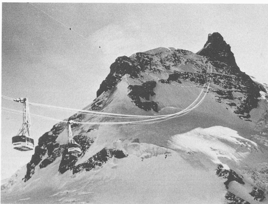
Fig. 1. — A la fin de 1979 le téléphérique du Petit Cervin (3883 m s. m.) sur Zermatt a été mis en exploitation. La construction a posé au constructeur des problèmes extraordinaires. Moins évidents, mais non moins exigeants se sont posés toute une série de problèmes géologiques/géotechniques dont quelques-uns sont décrits ici.
