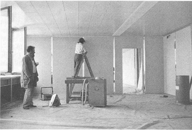
Fig. 10. — Montage des cloisons mobiles.
