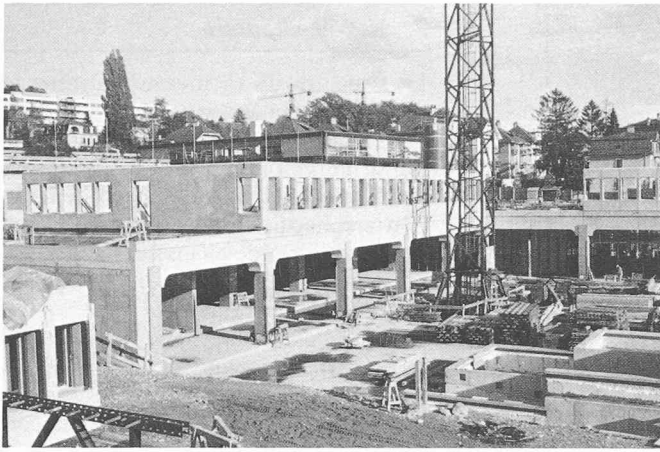
Fig. 8. et 9. — Pose des façades en éléments préfabriqués.
