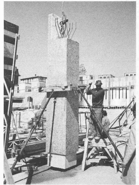
Fig. 16. — Pilier articulé au rez-de-chaussée.
