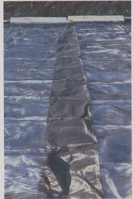
Fig. 14. — Recouvrement des laizes (tissé).
