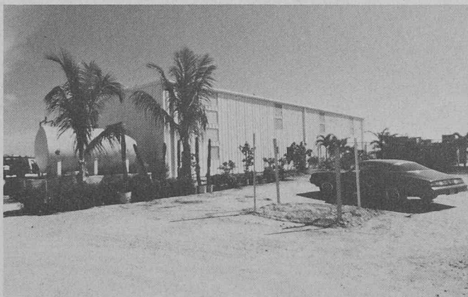
La nouvelle installation de dessalement de l'eau de mer par osmose inverse sur l'île Stock, près de Key West en Floride.
