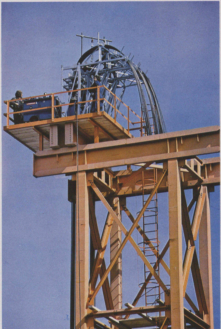
Tourelle de levage avec plateforme pour les vérins.
