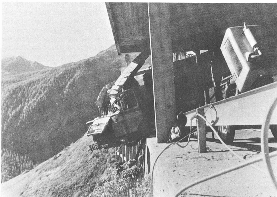
Fig. 10. — Accident survenu en 1971 sur le versant italien de la route du Grand-Saint-Bernard dans une galerie de protection contre les chutes de neige.
