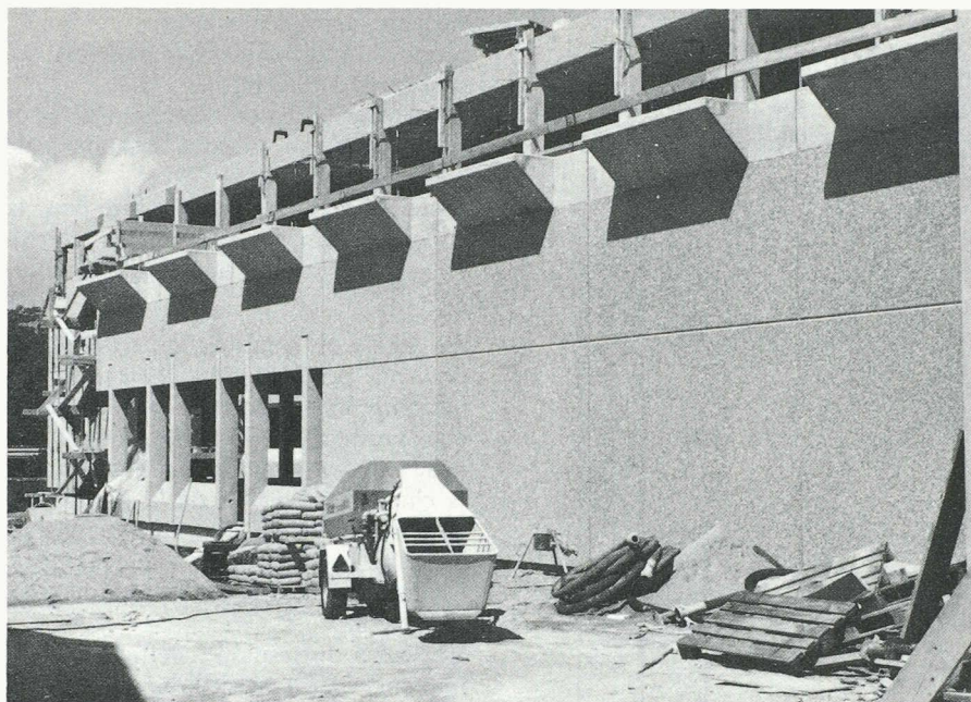
Façade sud: les consoles qui supporteront les bacs à fleurs.
