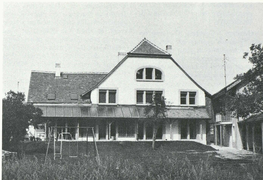
Fig. 3. — Vue de la façade sud, après transformation.
