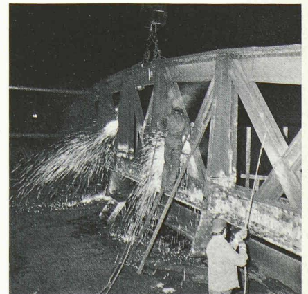
Fig. 2. — Démolition de l'ancienne structure à l'aide de grue-rails 25 t du type « Vevey », par l'équipe des ponts du 2 e arrondissement CFF.
