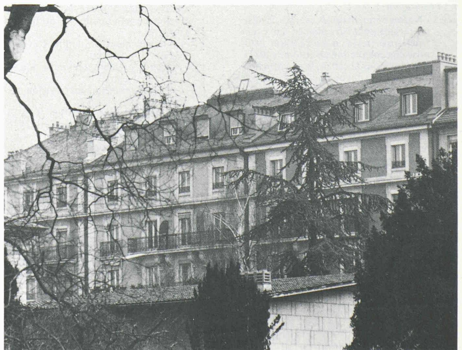
Rue des Rois: l'exemple existant (immeubles des numéros 7 et 9) qui permet d'imaginer la réhabilitation d'un «ensemble d'architecture identique» dans un quartier datant du début de notre siècle.
