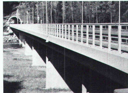
Pont sur autoroute Revêtement résistant au gel/dégel et aux sels à dégel
