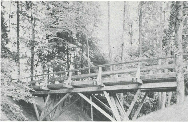
Fig. 2. — Passerelle en bois
