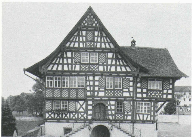
Fig. 3. — Oberaach/Suisse. Cette construction en colombage de grande valeur culturelle a été photographiée au moyen d'une chambre de prises de vues de haute précision (Wild P31, f=10 cm, f/8). Si cela s'avère nécessaire (restauration, dommages), il est possible, dans le restituteur photogramétrique Wild Aviolyt BC1, de mesurer avec précision le stéréogramme et de le transformer en un plan à l'échelle dans lequel de nombreuses droites sont tracées automatiquement ainsi que les courbes (fenêtres, portails).
