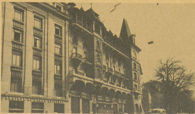
«Brûlé» en 1905, adoré en 1984: l'immeuble Camoletti!
