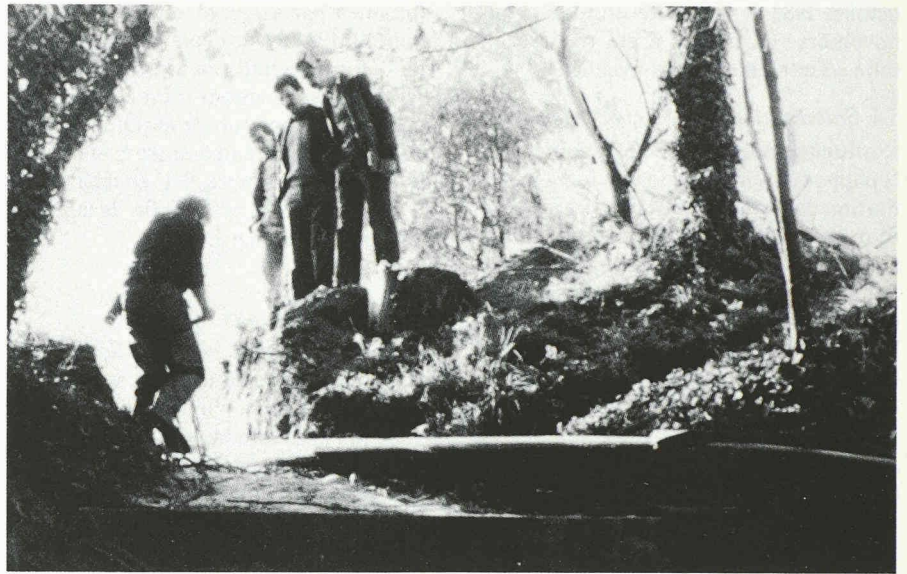
Fig. 4. — Constitution d'un réseau de chauffage à distance.
