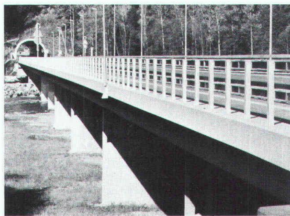
Pont sur autoroute Revêtement résistant au gel/dégel et aux sels à dégel
