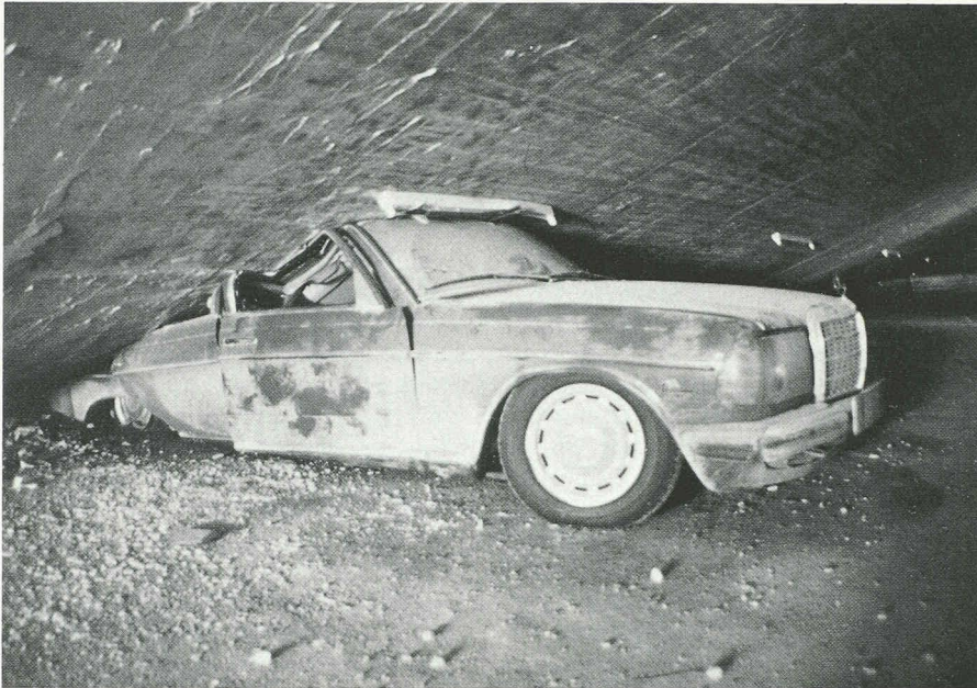
Fig. 1. — Une capacité portante insuffisante peut parfois avoir des conséquences catastrophiques (photo B. F. Gardel).
