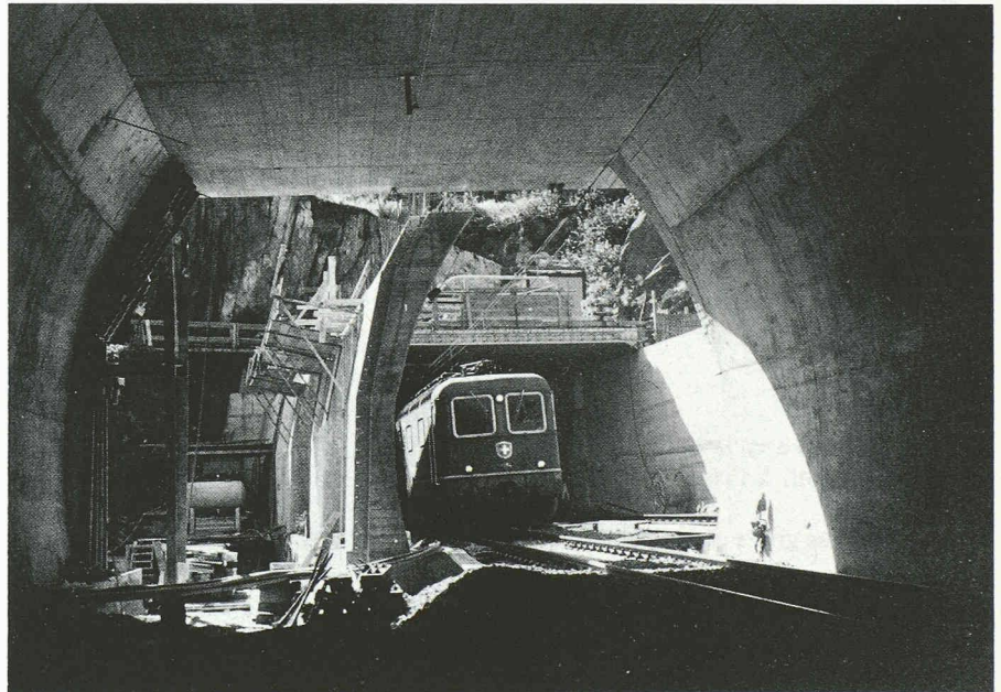
Mise en service après le premier ripage. Cette photographie correspond à l'état montré par la fig. 8.
