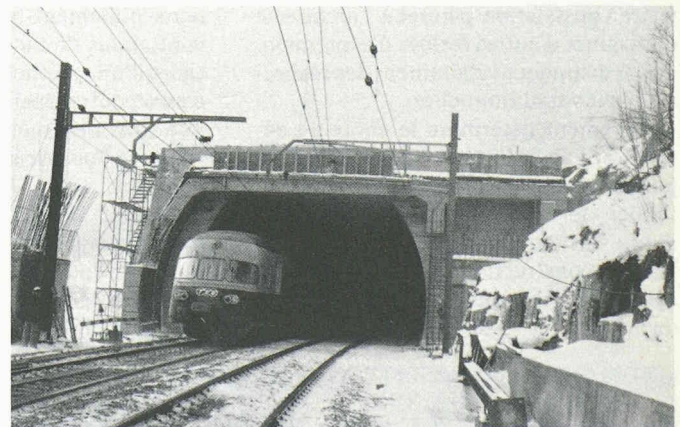
Deux ans et demi, avec deux hivers, séparent ces deux photographies. Les ponts métalliques ont disparu et le trafic s'écoule en toute sécurité sur le nouveau pont couvert, capable de résister aux avalanches. Sur la photographie de droite, on distingue les premiers travaux de la galerie qui prolongera le pont sur une longueur de 45 mètres.
