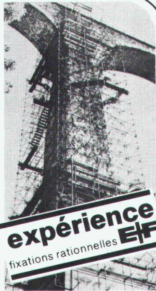
Fixation d'un coffrage
