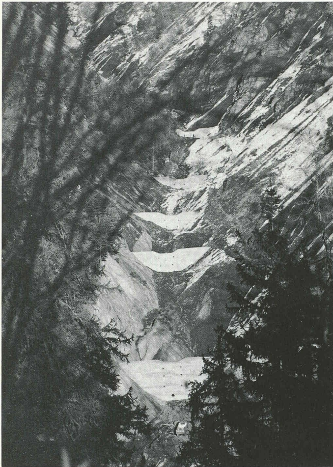
Fig. 12. — Vue de la correction du Grand-Torrent sur le Merdenson faite de seuils arqués en béton.
